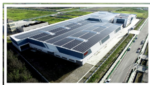
廠房工程：慶欣欣鋼鐵股份有限公司（總建坪 6991 坪）
