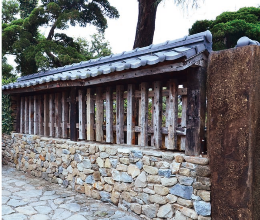
石積／日本古時堆積城牆的技法，全程不使用任何水泥等黏著物，每一塊石頭都是以鐵鎚敲打出想要的形狀，再一塊塊堆積成石牆、石柱。熊伯卿在日本學習此技能，成為台灣目前唯二懂得「石積」技術的師傅。
