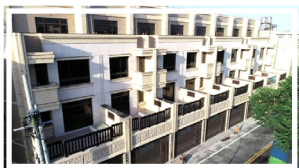
建築工程：智元開發建設有限公司（總建坪 980 坪）
